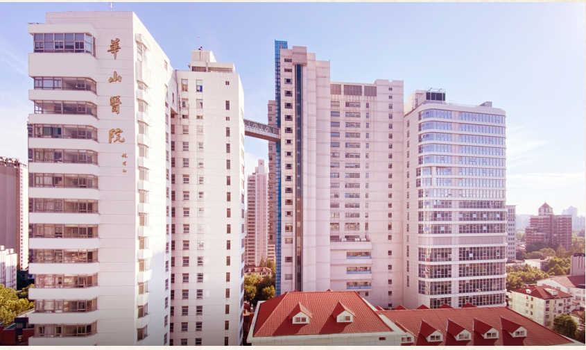
2022 年底,综合楼改扩建项目即将完成 大楼的落成将有效整合医院医教研资源,提升医院服务能级、增强百姓就医获得感,为医院高质量发展提供良好的条件,在实现空间倍增的同时,大幅提升医疗资源的配置及使用效率。
